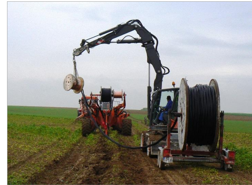
Photo 14 : Pose d'un câble HTA à 1,20 m avec la méthode du soc tracté (source VALOREM)
